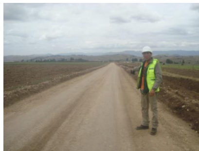
Vista del camino vecinal Condorccochoa-Secchapampa afirmado
