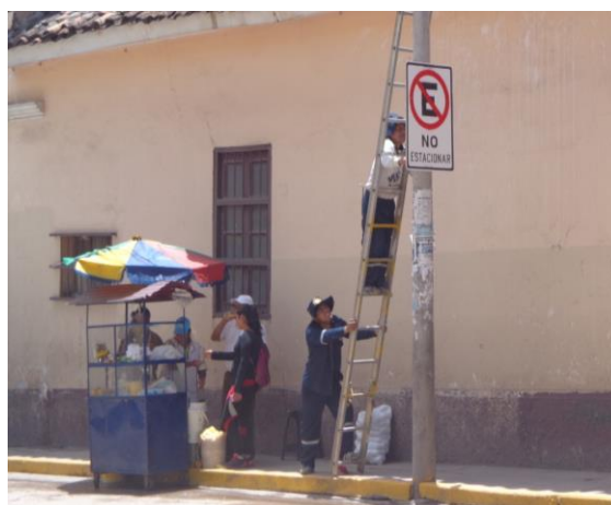
Colocación de señalizaciones NO ESTACIONAR en Av. Mariscal Cáceres
