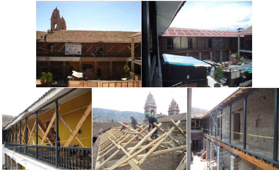
Vistas fotográficas de rehabilitación del Palacio Municipal
