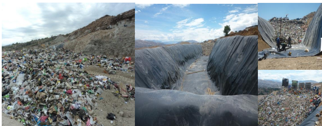
Instalación de geo membrana de tipo trinchera para el tratamiento de residuos sólidos
