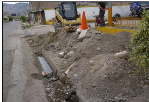
Habilitación de hoyos en vía vehicular de
