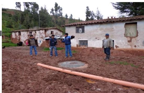
Vista de Sistema de agua potable e Instalación de Red Alcantarillado y Tratamiento Primario (Tanque Séptico) en la Comunidad de Yanayacu, Distrito de Socos
