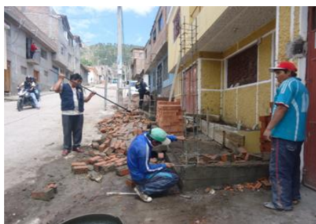
Fiscalización y demolición de muro fuera del alineamiento
